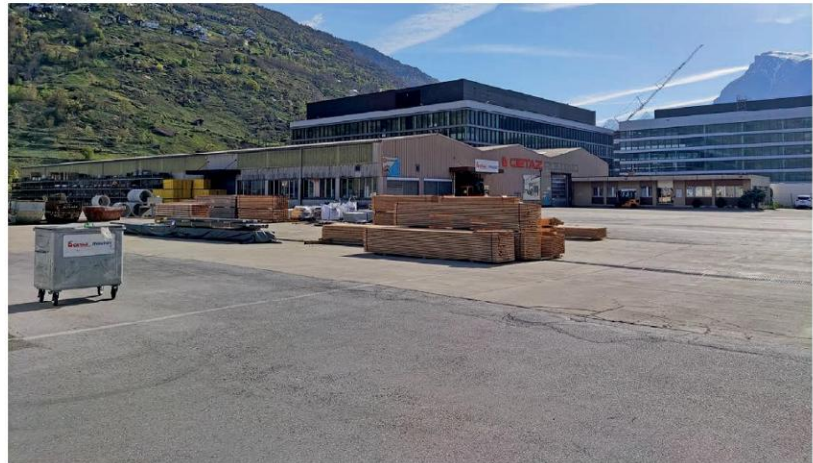
Am bestehenden Standort in den Visper Kleegärten plant Gétaz Miauton einen vier Millionen Franken teuren Annexbau, wo künftig die Bereiche Sanitär, Fliesen und Baustoffe ausgestellt werden. Eine Küchenausstellung wird es indes nicht mehr geben.
